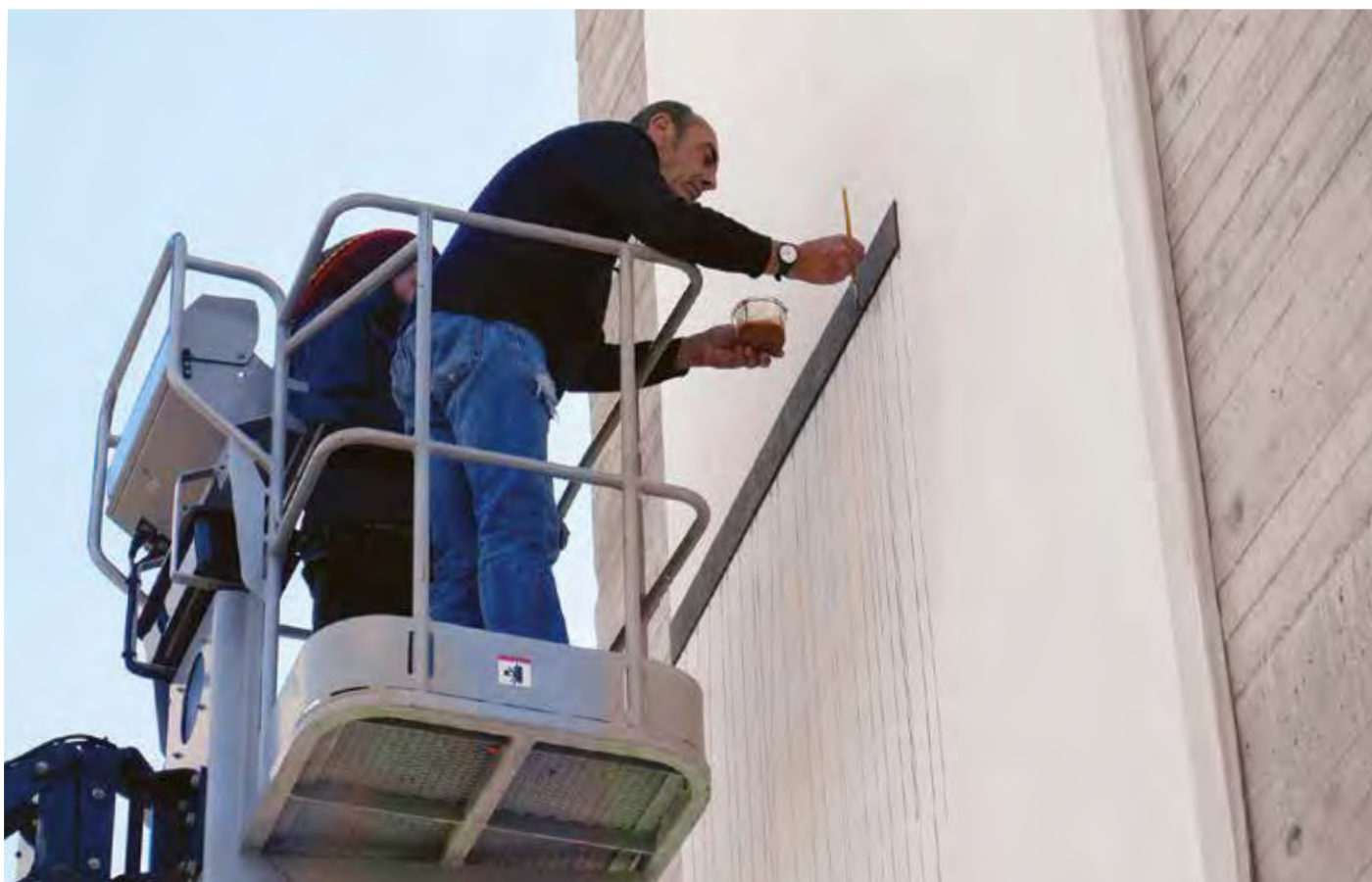
Installation par Michel Mouffe de son œuvre Les larmes de Saint Pierre, sur la facade arrière du Musée. Don des Amis du Musée L.
